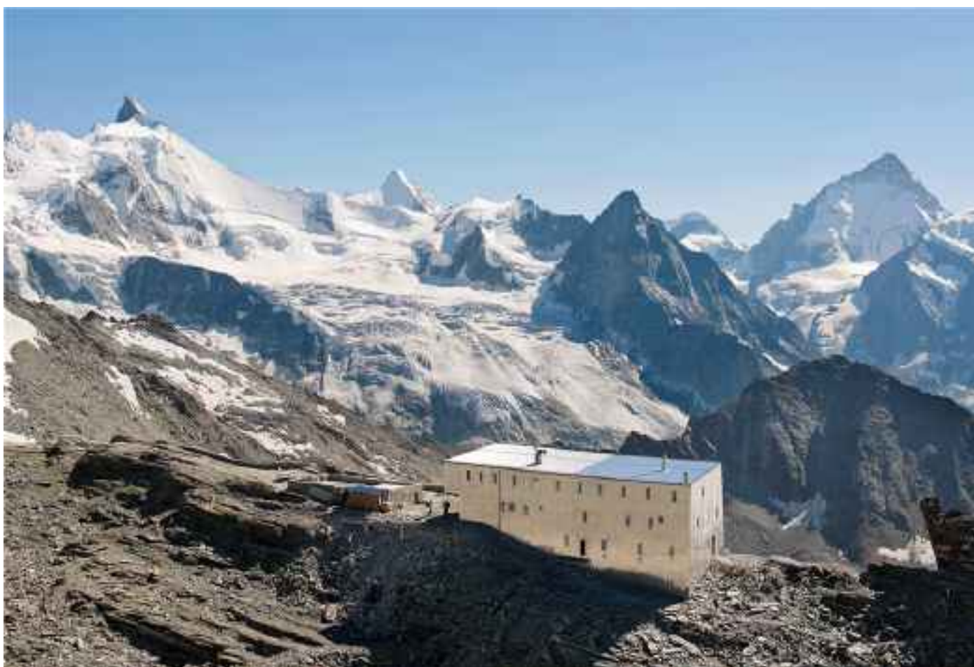
Automation de la cabane de Tracuit par SDAutomation: solutions high-tech pour le confort des férus de haute montagne.
